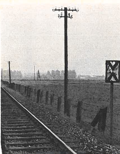
Die Vorsignaltafel Ne 2 steht hier an Stelle eines Vorsignals zur Kennzeichnung des Bremswegabstandes der Strecke vor dem Hauptsignal.
